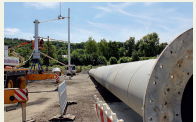
▶ Hier, lors du montage de l'éolienne sur le site de l'entreprise Nonet.
